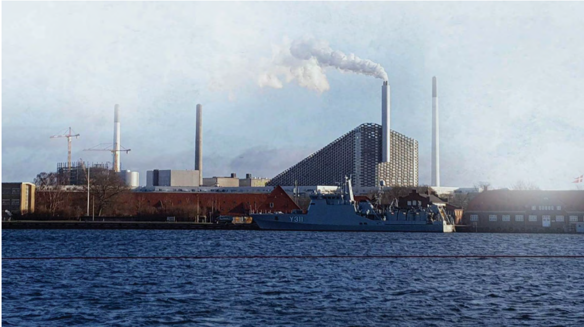
תמונה מס' 3: Copenhill Amager Bakke WtE Copenhagen Denmark
