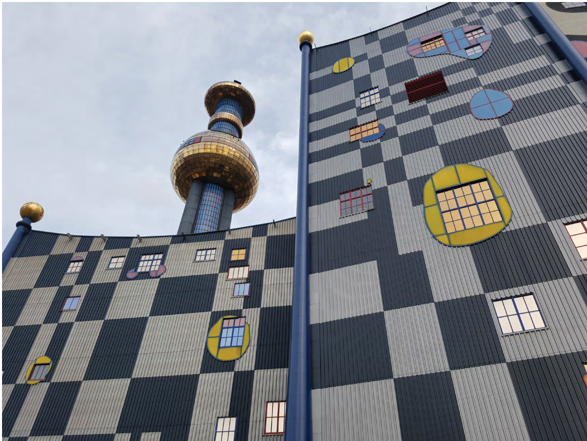
תמונה מס' 1: Spittalau Waste to Energy, Vienna, Austria
